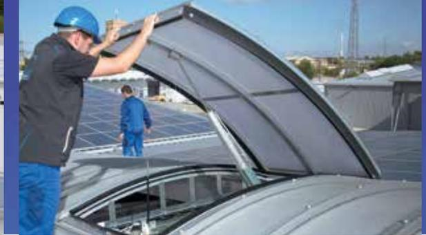
RWA-Öffnungen notwendig, da hier im geöffneten Zustand bei Wartung oder in Lüftungsstellung der außenliegende Schutz seine Funktion verliert. Verkehrswegesicherungen sind als eingeschränkter Primärschutz zu verstehen. Sie bieten außenliegenden Schutz für auf dem Dach arbeitendes Fachpersonal. Sie bieten jedoch keinen Kollektivschutz, ein Durchstürzen ist in Fällen des missbräuchlichen Verwendens von Oberlichtern möglich.
