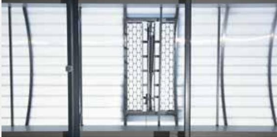
Bild 1.0 Innenansicht Lichtband: DSS\_S Lichtbandklappe DSS\_A mit RWA
