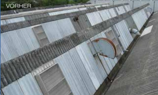
Eine Entscheidung, viele Vorteile – die Sanierung von undichten oder defekten Lichtbändern bzw. RWA-Geräten erfüllt nicht nur die verschärften Normen und Regelwerke. Sie tätigt auch eine direkte Einzahlung in den Geldbeutel – denn schon eine Sanierung mit heute üblichen Standard-Verglasungen spart richtig Energie.
